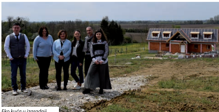
Eko kuća u izgradnji
